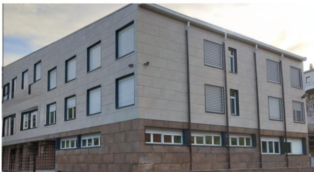
CIFP Las Ferrerías, en Arenas de San Pedro
